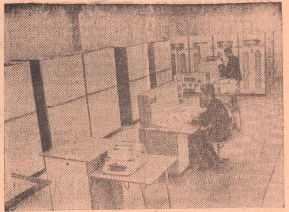
На Южуралмашзаводе полным ходом идет монтаж и наладка электроно-вычислительной машины «Минск-22». НА СНИМКЕ: специалисты вычислительного центра завода ведут отладку отдельных блоков машины.
