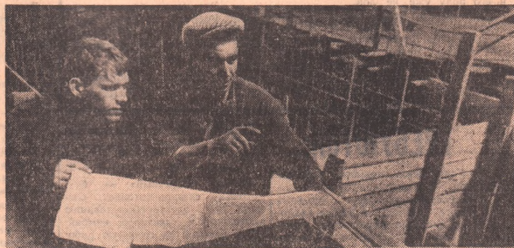
В эти дни бригадир плотников-бетонщиков цеха руководил Павлом Емельяновичем Приходько (строительное управление № 2 треста «Орскпромстрой») возводит фундаменты второй очереди комплекса прокат и выстанов на заводе по обработке цветных металлов. 120-130 процентов годовых, каждую смену показатели труда этого коллектива. НА СНИМКЕ: бригадир П. Е. Приходько (справа) и плотник А. Дабулд. Фото И. НЕСТЕРОВА.
