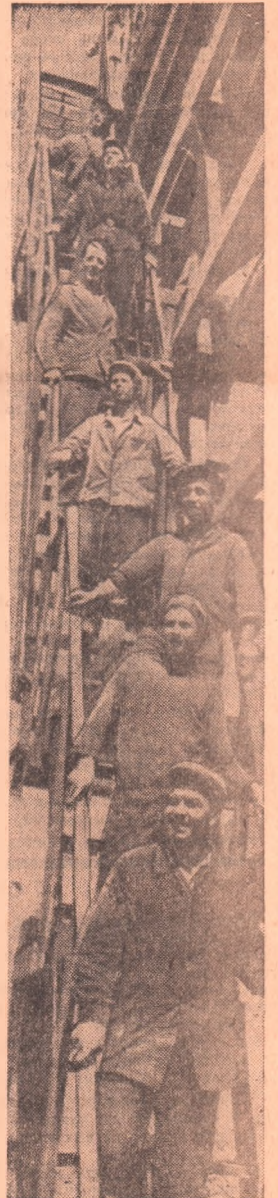
Хорошими делами прославился в семье «Орскострой» бригада плотников, которую возглавляет коммунист Павел Алексеевич Царгородцев. На многих стройках города трудился коллектив. И ведь он успешно справлялся с заданиями. Сейчас передовая бригада работает на строительстве градирни новой кислородной станции никелькомбината. Она готовит достойные трудовые подарки анимательной лете — 100-летию со дня рождения В. И. Ленина. Фото И. ЕВГЕНЬЕВА.
