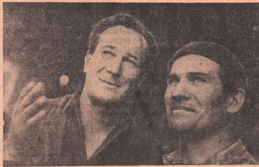
ТЕПЛОЭЛЕКТРОЦЕНТР А Л Б № 4. В тепловом цехе предприятия — капитальный ремонт турбины. Ведет его бригада слесарей Орского участка «Ураль-энергоремонт», возглавляемая Павлом Александровичем Борисовым. Коллектив ремонтников обязался закончить все работы к 8 июля. Слово свое он держит крепко, выполняет работу строго по графику.
