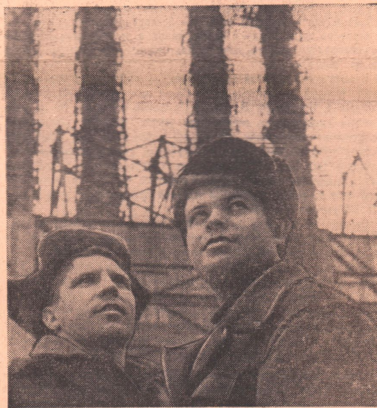
ЗАВОД СИНТЕТИЧЕСКОГО СПИРТА. Александр Кочегаров и Виталий Мельников ремонтируют технологическое оборудование в цехе упарки серной кислоты. Они в числе передовиков производства, отлично справляются со своими обязанностями. Качество ремонта всегда отличное. Фото И. Нестерова.
