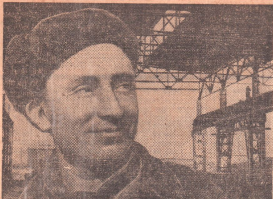
СТРОИТЕЛЬНОЕ УПРАВЛЕНИЕ ТРЕСТА «ОРСКПРОМСТРОЙ». Коммунист Владимир Николаевич Егоров возглавляет передовую бригаду плотников-бетонщиков, которая работает на сооружении второй очереди производного цеха завода по обработке цветных металлов. НА СНИМКЕ: В. Н. Егоров. Фото И. ЕВГЕНЬЕВА.
