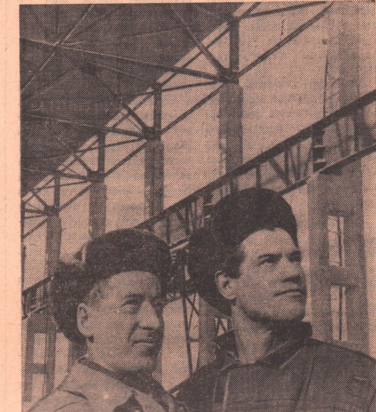
Петр Яковлевич Федоров и Михаил Филиппович Семенов — лучшие плотники-бетонщики в бригаде тов. Егорова из строительного управления № 1 треста «Орскпромстрой». Они высокопроизводительно трудятся на сооружении фундаментов второй очереди прокатного цеха завода по обработке цветных металлов. Фото И. Нестерова.
