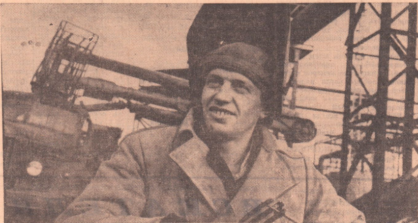
На строительстве кислородной станции комбината «Южуралникель», пускового объекта, с каждым днем растут темпы работ.
