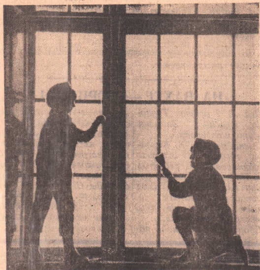
ТРЕСТ «ОРСКПРОМСТРОЙ». Скоро трикотажная фабрика вступит в действие. А пока здесь идут отделочные работы.
