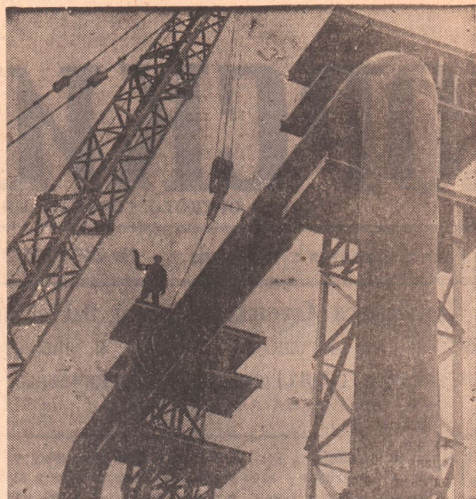
Идет монтаж кислородопровода в плавильный цех комбината «Южуралникель». Его монтирует передовая бригада, возглавляемая М. Д. Украинским.
