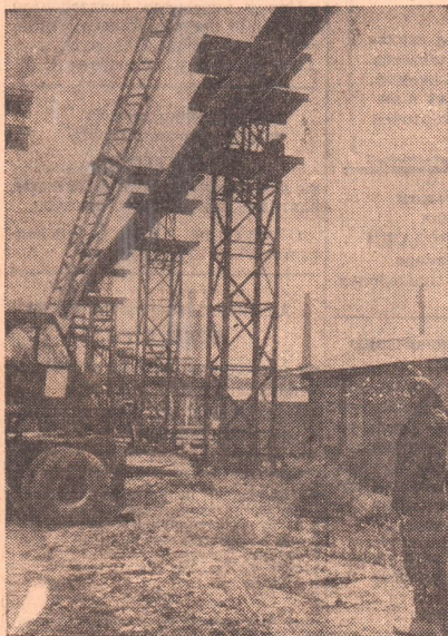
ПОЛНЫМ ХОДОМ ИДУТ РАБОТЫ НА СТРОИТЕЛЬСТВЕ ПУСКОВОГО ОБЪЕКТА ОБЪЕДИНЕННОГО ГОДА — КИСЛОРОДНОЙ СТАНЦИИ НИКЕЛЕВОГО КОМБИНАТА. ОНА ДОЛЖНА ВСТУПИТЬ В СТРОЙ УЖЕ В ЧЕТВЕРТОМ КВАРТАЛЕ.
