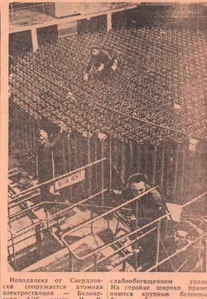
Неподалеку от Свердловска сооружается атомная электростанция — Белоярская АЭС имени И. В. Курчатова. Первая очередь АЭС мощностью 100 тысяч киловатт войдет в строй в 1962 году. Сейчас на всесоюзной ударной комсомольской стройке построены машинный зал, электроподстанция, идет монтаж первой турбины и первая реактора, который будет работать на
