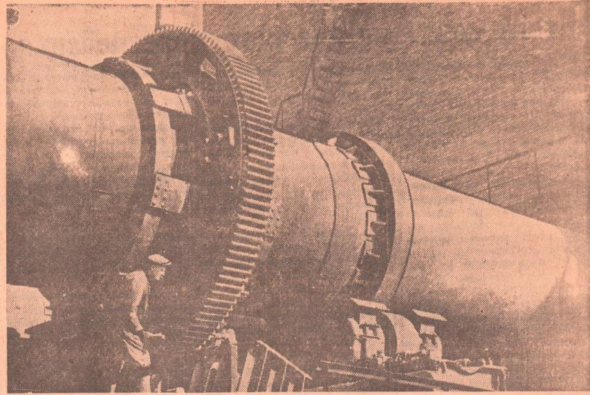
Витебск. Подходит к концу строительство и монтаж керамзитового завода по производству нового строительного материала для заполнения железобетонных конструкций. Керамзит в виде шариков изготавливается из глины методом обжига во вращающихся печах при температуре до 1.200 градусов. Он в 7 раз легче гравия, не тонет в воде и значительно облегчает вес сборных конструкций.
