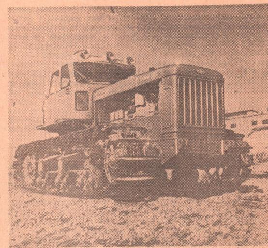
Коллектив тракторостроителей Брянского автомобильного завода изготавливает новый трактор Т-220 мощностью 220 лошадиных сил. Он предназначен для выполнения больших объемов земляных и других работ на строительстве плотин, дамб, каналов, шоссейных и железных дорог. Кабина трактора изготавлена из стеклопластика с двойными стенками, заполненными поролоном. Это обеспечивает высокую тепло- и звукоизоляцию. Новый трактор создан коллективом предприятия в подарок XXII съезду КПСС.
