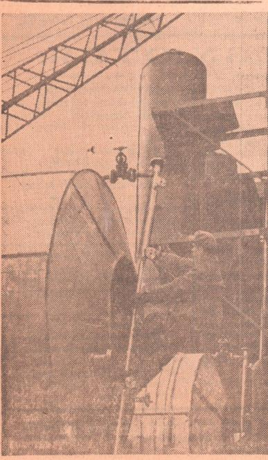
На снимке: сборка арматуры на емкостях готовой продукции.
