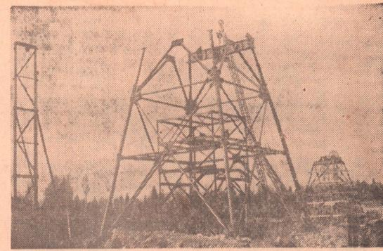
Свердловская область. Год назад здесь шумела тайга, а сейчас один за другим растут копры новой шахты, которая будет самой глубокой на Северном Урале. Серовские шахтостроители одновременно ведут проходку пяти стволов, монтаж двух копров, развернуто строительство комбината бытового обслуживания, подстанции и других помещений.
