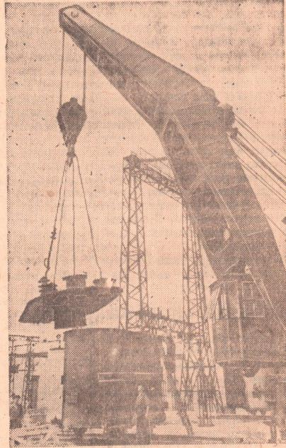
На Кимперской рудоуправлении никелькомбината заканчивается монтаж нового мощного трансформатора. С вводом его в эксплуатацию электроэнергии будут обеспечены рудники управления и прилегающие колхозы Степного района Актюбинской области.
