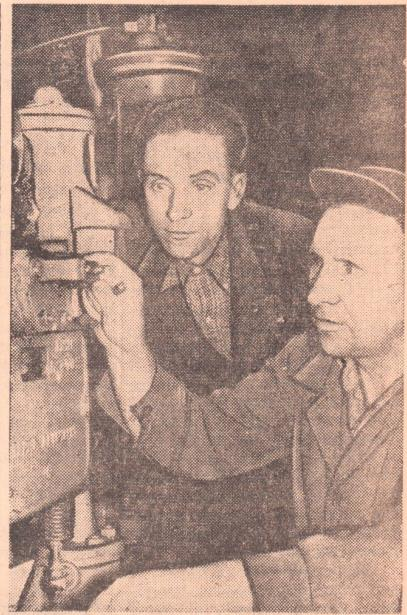
ТЭЦ № 1. Ст. машинист тов. Медведев и начальник смены тов. Киничкин проверяют осевой зазор турбины. Агрегат работает хорошо. Фото Б. ТАНА.
