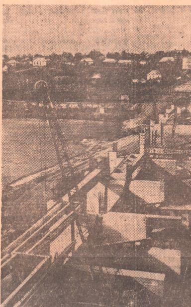
Украинская ССР. На реке Южный Буг в г. Гайворон Кировоградской области строится межрайонная гидроэлектростанция. Эта электростанция, как и мощная Кременчугская ГЭС на Днепре, сооружается без машинного зала. На строительстве широко применяется сборный железобетон. В 1962 году Гайворонская ГЭС должна дать электроэнергию Гайворонскому и соседнему, Ульяновскому району.
