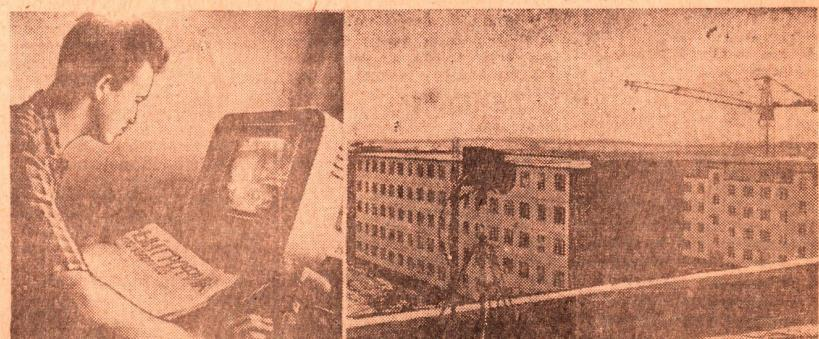
Ленинград. На строительстве жилых домов в 126-м квартале Щемиловки, где монтаж зданий ведет домостроительный комбинат № 2 Главленинградстроя, применена промышленная телевизионная установка ДТУ-4М. Четыре передающие камеры позво-
