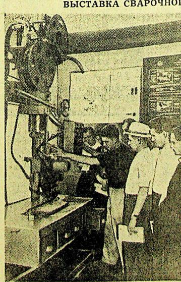
Москва. В павильоне «Машиностроение» на ВДНХ открыта тематическая выставка «Внедрение передовой сварочной техники в народное хозяйство СССР». Среди новейших сварочных машин и автоматов — установка «ТФД-1000», предназначенная для сварки трехфазной лугой главным образом низколегированных и углеродистых сталей швами большого сечения.
