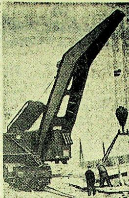
Дизельный подъемный кран, применяемый для погрузки мостовых пролетов.
