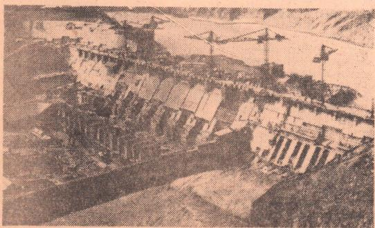
Китайская Народная Республика. В ущелье Саньмынься в провинции Хэнань возводится плотина высотой выше ста метров и здание гидроэлектростанции. Плотина преградит путь Хуанхэ и сможет задерживать большую часть паводковых вод в водохранилище емкостью в 35 миллиардов кубометров. Гидротехнический
