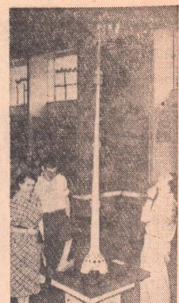
Москва. В разделе «Строительство» Выставки достижений народного хозяйства СССР установлен макет новой телевизионной башни, которая будет построена в Москве. Высота этой железобетонной опоры составит 508 метров. В башне спроектированы три зала ресторана на разных высотах и 4 смотровые площадки для экскурсантов. Конструкция башни разработана отделом новой техники института «Моспроект».
