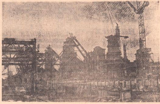
Свердловская область. Предмайская трудовая вахта строителей новой домны Нижне-Тагильского металлургического комбината началась с монтажа стального кожуха печи. Коллектив «ударной стройки», добившийся в марте рекорда по заливке фундамента домны (2200 кубометров бетона, уложены за 44 часа), в апреле одержал новую победу. Стальной кожух этой крупной домны, а также колонны горна и колыцевой воздухопровод смонтированы всего за 10 дней, вместо 25, предусмотренных уполномоченным графиком.
