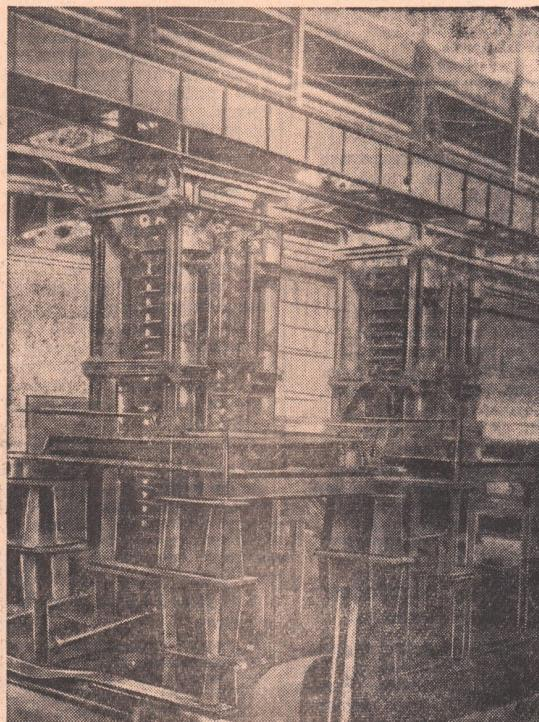
Упорно поработал коллектив машиностроителей над установкой для непрерывной разливки стали. Эта машина отправлена на Ново-Липецкий завод.
