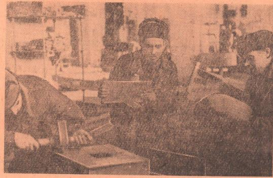
Ремонто-механический завод треста «Южуралтяжстрой». Сборка элементов линии электропередачи Орск—Медногорск.
