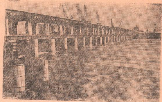
На строительстве Сталинградской гидроэлектростанции затоплен котлован ГЭС. Перемычка, отделявшая Волгу от котлована, была взорвана, и вода забила рибсерьму нижнего бьефа гидроэлектростанции.
