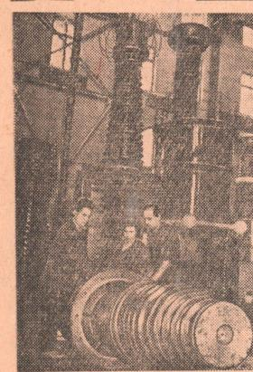
На московском заводе «Изолятор» изготовлены мощные вводы для новой линии электропередачи Куйбышев — Урал. Вводы рассчитаны на напряжение 220 и 500 киловольт.
