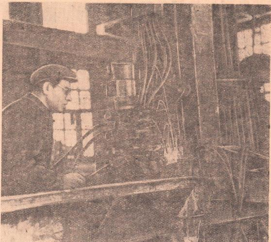
На Южуралмашзаводе электрошлиаковой сваркой сварена первая партия стеллук к холодильникам. Вес каждой детали достигает 20 тонн.
