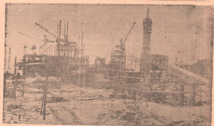
Успешно идут работы на строительстве второго дробильно-агрегационного цеха на никелькомбинате. Молодые рабочие треста «Южуралтэжстрой», обладающие этим строительством, делают все для того, чтобы к установке ленточного конвейера вторая аглофабрика вступила в строй.
