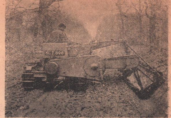
В дорожном хозяйстве Англии широко используются для очистки кюветов и канав машины «Линкол». Изготавливаемые в Англии машины типа «Линкол» применяются и в сельском хозяйстве. Движаясь вдоль кювета или канавы, агрегат вычищает ил, грязь или траву. Агрегат установлен на тракторе и приводится в движение тракторным двигателем через роликовую цепь.
