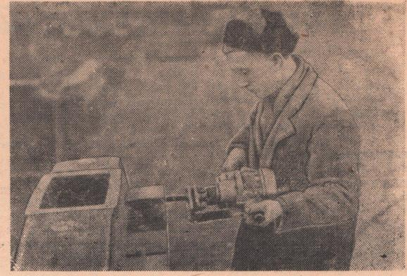
Начальник участка цеха коксового оборудования Южуралмаш завода тов. Бирюков и бригадир тов. Шкуркин создали специальное приспособление к пневматической сверлильной машине. Его применение резко подняло производительность труда при нарезке резьбы. На снимке: тов. Бирюков ведет нарезку резьбы с помощью нового приспособления.
