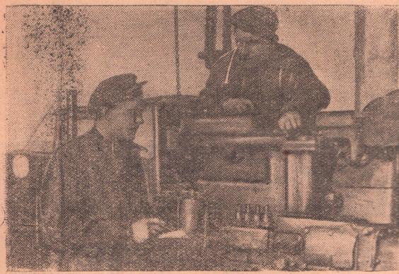
Начальник ОТК моторемонтного завода тов. Гринцов (слева) и бригадир тракторной бригады Адамовской МТС тов. Матченко проверяют качество ремонта мотора трактора «С-80».
