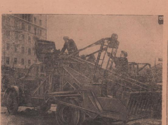
Московский экспериментальный завод сельскохозяйственного машиностроения закончил сборку двух свеклопогрузчиков конструкции лауреата Сталинской премии М. Обрывко. Новая машина создана на базе автомашин «АЗ-51» и предназначена для механической погрузки свеклы. Производительность машины до 25 тонн в час.
