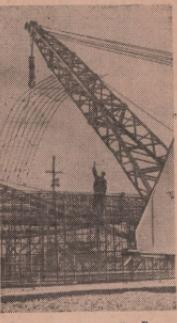
Сталинградгидрострой. В котловане № 30 и водосливной плотине развернулись бетонные работы. Одновременно с укладкой плиты ведется установка железной арматуры.
