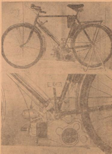
Советские конструкторы разработали и внедрили в производство новый, очень эффективный колесный велосипедный мотор «Иртыш», предназначенный для облегчения передвижения инвалидов.
