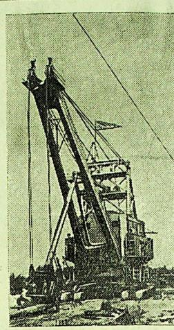
Украинская ССР. Коллектив Николаевского машиностроительного завода имени Сталина одержал новую производственную победу. Здесь изготовлен 15-кубовый экскаватор. Высота его 33 метра. Изготовленный экскаватор заменил на земляных работах 7 тысяч человек. В ближайшее время партия этих мощных машин начнет работать на берегах Волги.
