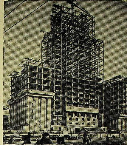
Москва. Строительство административного многоэтажного здания площади За разработку и освоение скоростных методов сооружения стального каркаса этого здания инженерам треста «Стальконструкция» Л. Шипакину, А. Соколову и А. Федорову, инженерам треста «Проектстальконструкция» Н. Мельникову, Б. Шумилину и главному инженеру Днепропетровского завода металлоконструкций имени В. М. Молотова Д. Лебедю присуждена Сталинская премия. (Фото ТАСС).
