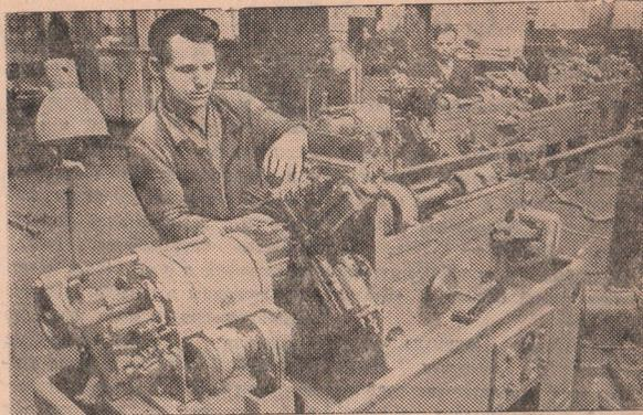
Ленинград. На станкостроительном заводе «Автомат» сконструирован автомат с револьверной головкой для продольно-фасонного точения: на таком станке обрабатываются металлические прутки диаметром от 18 до 25 миллиметров.
