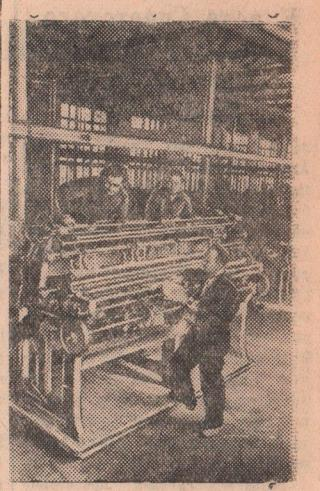
Ленинград. На заводе имени Энгельса изготовлена новая основная машина, вырабатывающая трикотажное полотно. За 8 часов она изготавливает 15—18 килограммов высококачественного тонкого полотна из хлопчатобумажной пряжи.
