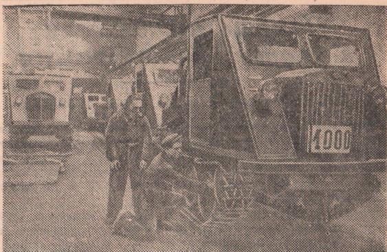
Ленинград. На главном конвейере сборочного цеха Кировского завода. На снимке: бригадир А. М. Павлов (справа) и слесарь-сборщик П. А. Шигорин натягивают гусеницу на трелевочный трактор.
