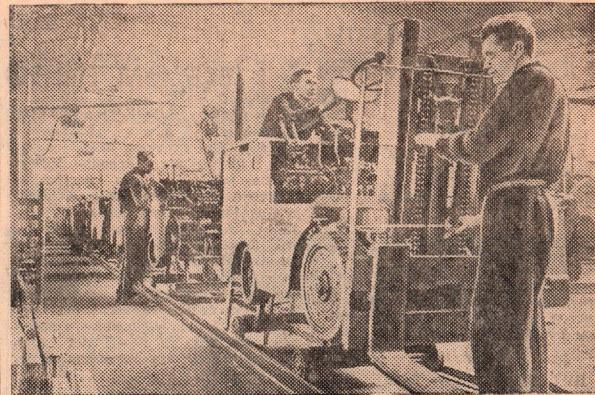
Московский завод транспортного машиностроения имени Орджоникидзе освоил серийный выпуск автопогрузчиков грузоподъемностью 1,5 тонны.
