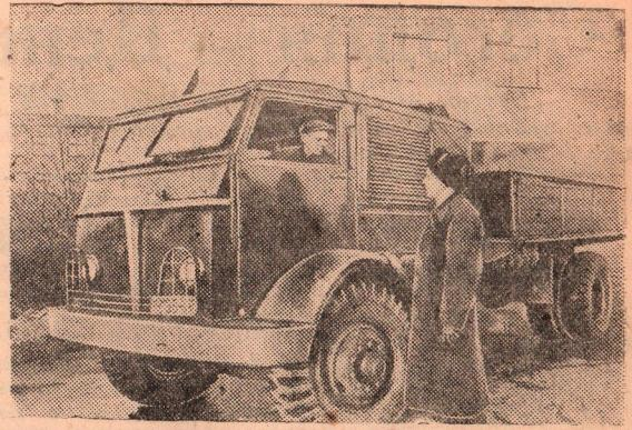
Москва. Конструкторское бюро паровых автомобилей научно-исследовательского автомобильного и моторного института (НАМИ) создало мощный 6-тонный паровой автомобиль, предназначенный для перевозки грузов в лесных и угольных районах. Горючим для новой машины служит дрова (длина до полуметра) или уголь.
