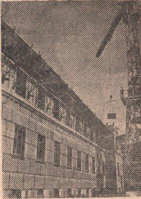
Ленинград. В Благодатном переулке (Московский район) строится пятиэтажный дом. Он будет иметь 3520 квадратных метров полезной площади. Дом строится из крупных блоков, изготовленных заводским способом. Весь рабочий и технический персонал строительства пятиэтажного здания состоит из 42 человек.
