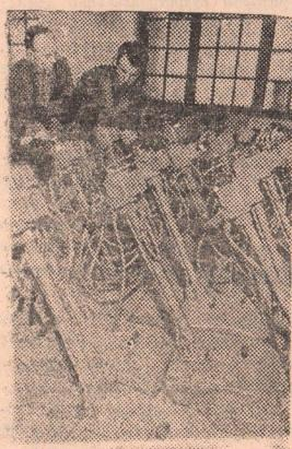
Украинская ССР. Одесский завод строительно-отделочных машин освоил массовый выпуск новых машин для отделки бетонных, мраморных, мозаичных и паркетных поверхностей. Машины, конструкция которых разработана Всесоюзным научно-исследовательским институтом Министерства строительного и дорожного машиностроения, отличаются высокой производительностью; каждая из них заменяет работу 15—18 человек. В этом году будет выпущено 2500 строительно-отделочных машин.
