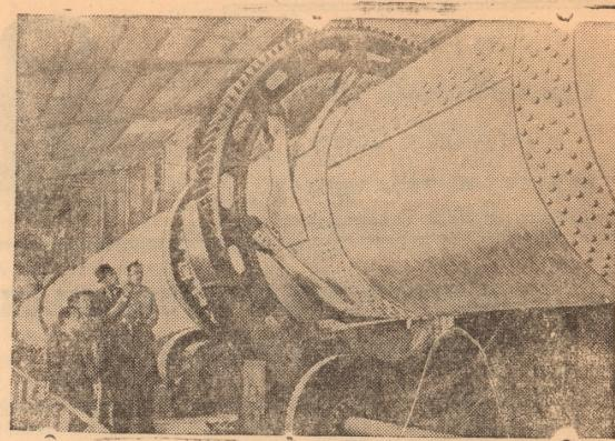
Латвийская ССР. Досрочно сдана в эксплуатацию первая очередь восстанавливаемого Броценского цементного завода. Значительно расширяются старые цеха, строятся новые. К концу пятилетки производственная мощность завода превысит довоенную.
